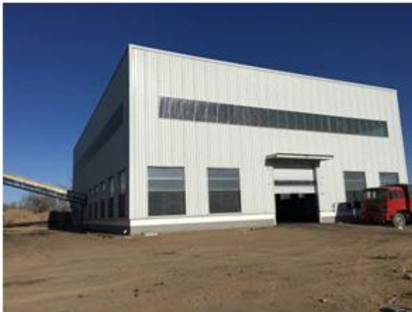
全封闭的储煤棚
