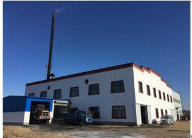
锅炉房及锅炉烟囱
