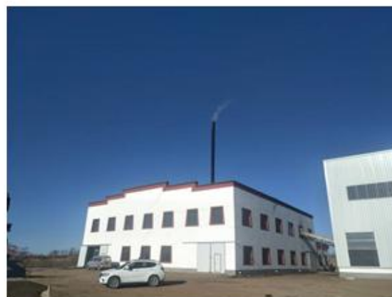
锅炉、鼓风机、引风机集中布置在锅炉房内
